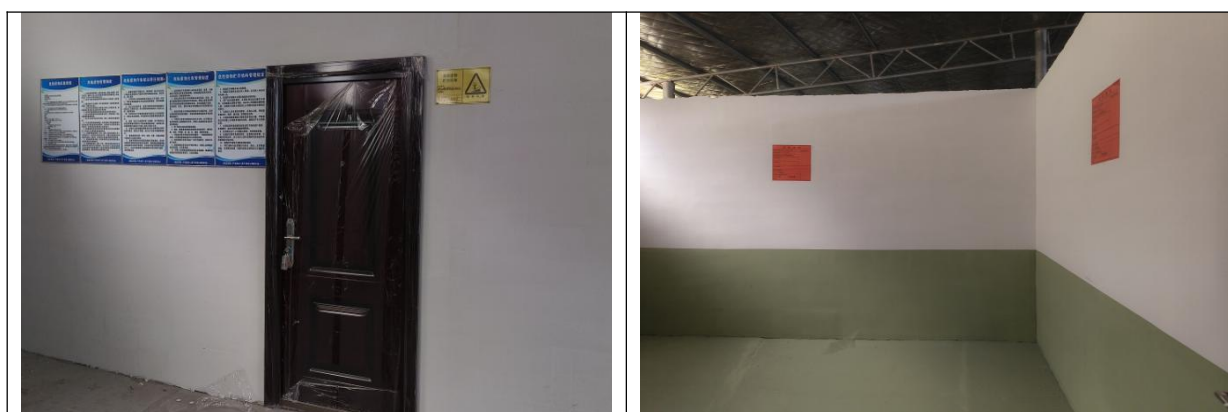
图 3-2 危废仓库现场图
