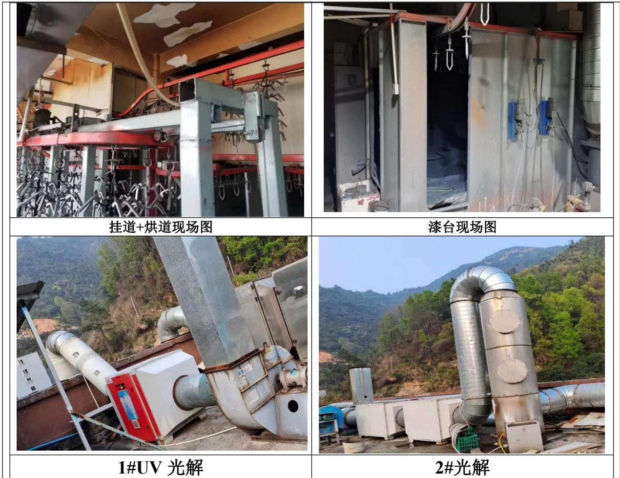
图 4-1 项目废气产污结点和处理设施现场图
